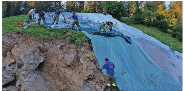
. . . wurde mit Planen gesichert
