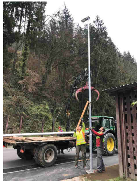
Aufstellen der neuen Straßenbeleuchtung
