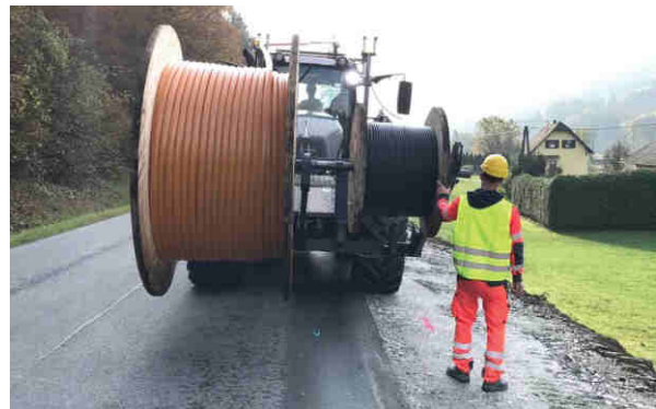
System Layjet (gleichzeitige Verlegung beider Kabel)
