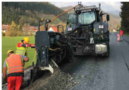
System Layjet (Kabelfräse- entwickelt vom Land Steiermark) bei der Verlegung der Kabel.
