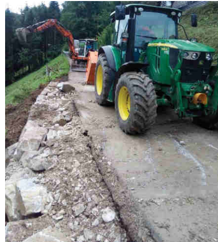
HW-Sanierung im Ortsteil Kohlschwarz
