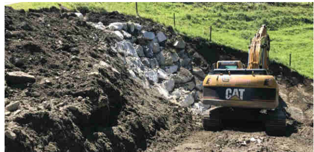
HW-Sanierung im Ortsteil Gallmannsegg „Gurzgruber“
