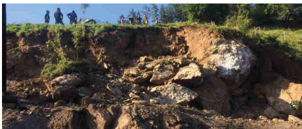
Die Hangrutschung nach einem Starkregen . . .
