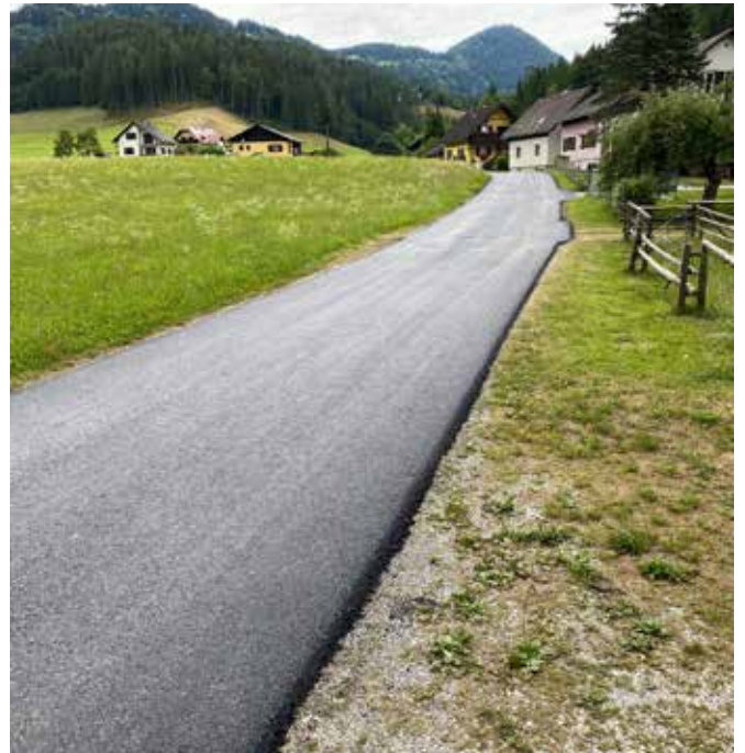
Asphaltierung im Krametergraben
