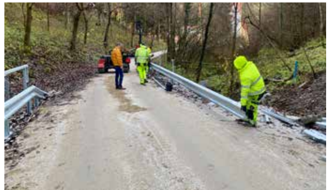
Montage der Leitschiene
