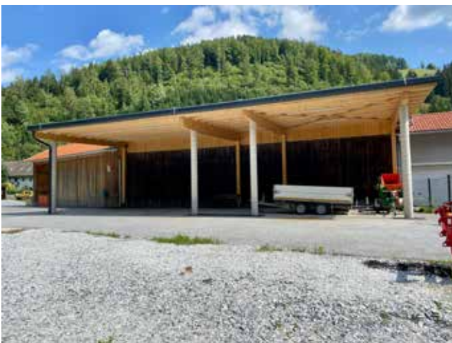
Neuer Zubau Lagerhalle
