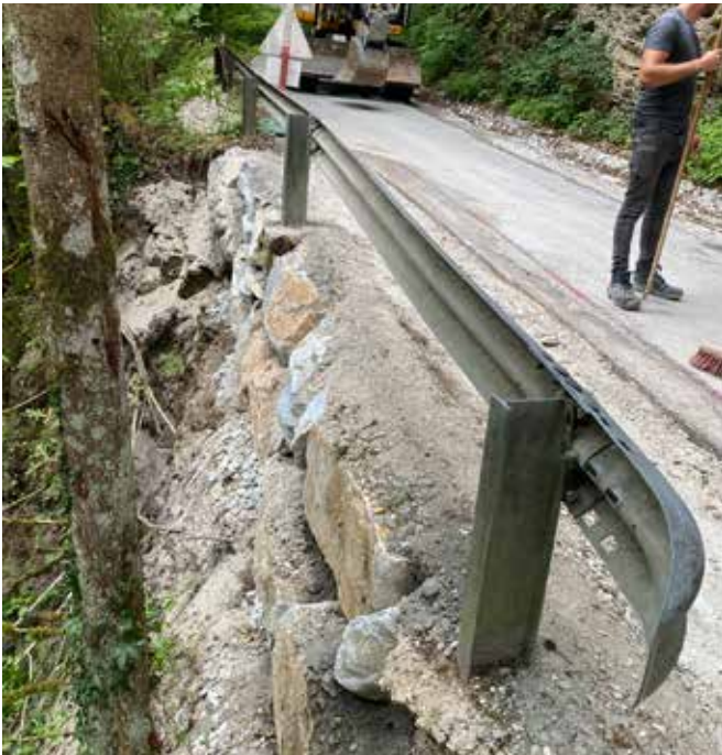
Sanierung erste Rutschung im Millionengraben
