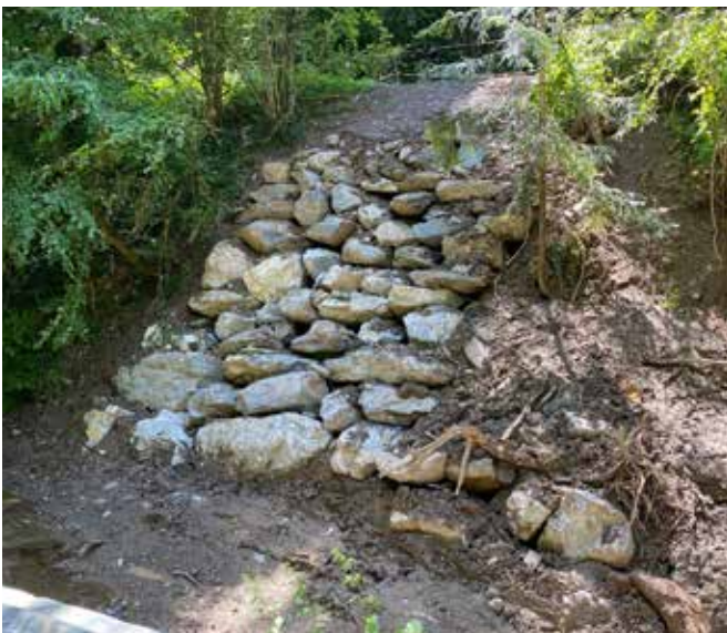
Sanierung zweite Rutschung im Millionengraben
