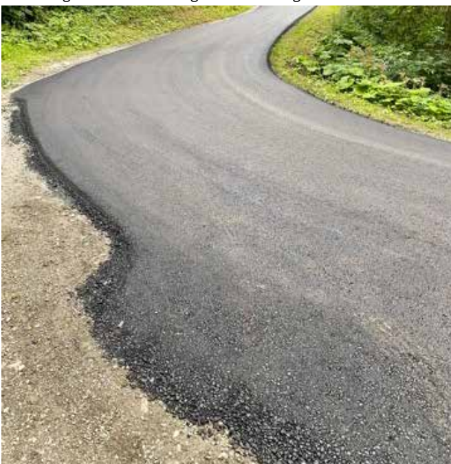
Asphaltierung im Forstbauergraben
