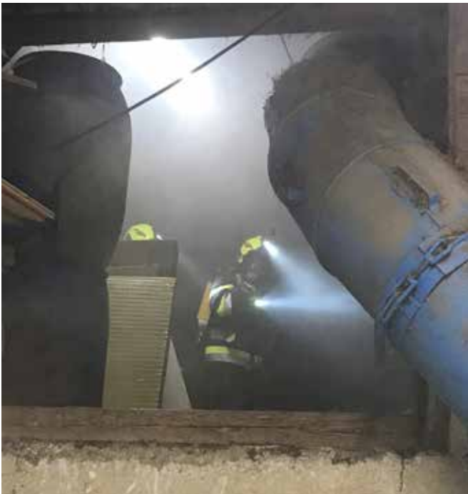
Brand einer Hackschnitzelanlage
