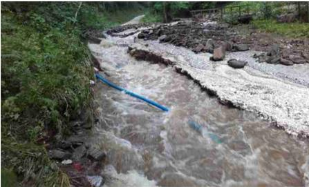
Der Hochbehälter wurde somit nicht mehr mit dem hochwertigen Trinkwasser gespeist. Eine Begehung zeigte jedoch weitere Schäden. So zum Beispiel im Bereich der Bachquerung I (Hirtlweg). Die zerstörerische Kraft des Wassers hat unsere Leitung unterspült und ebenfalls völlig frei gelegt.
